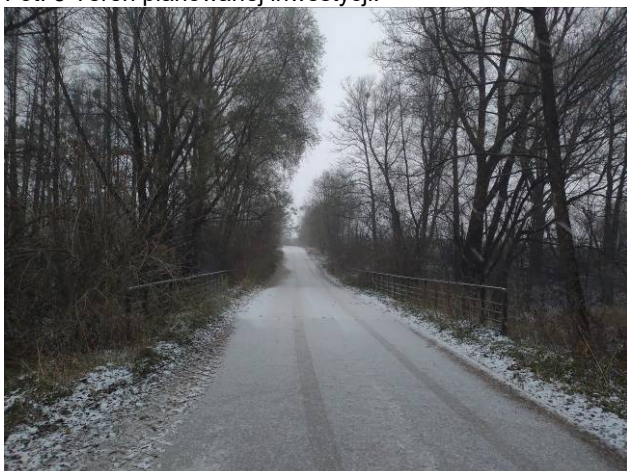
Fot. 5 Teren planowanej inwestycji – most na rzece Lega.
