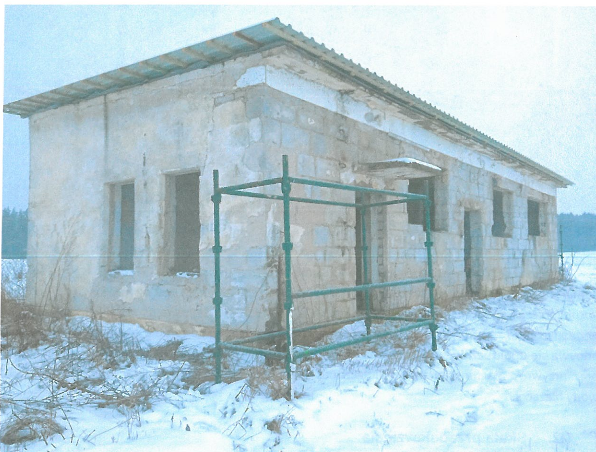
Rys. 1.1. Widok z zewnątrz na budynek „izolatkę” – luty 2022 r.
