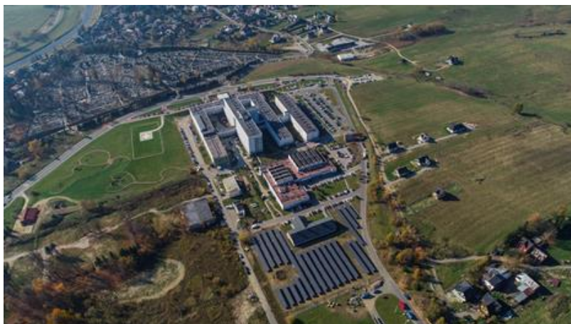
Farma fotowoltaiczna zlokalizowana przy stacji dializ Podhalańskiego Szpitala Specjalistycznego w Nowym Targu 10
