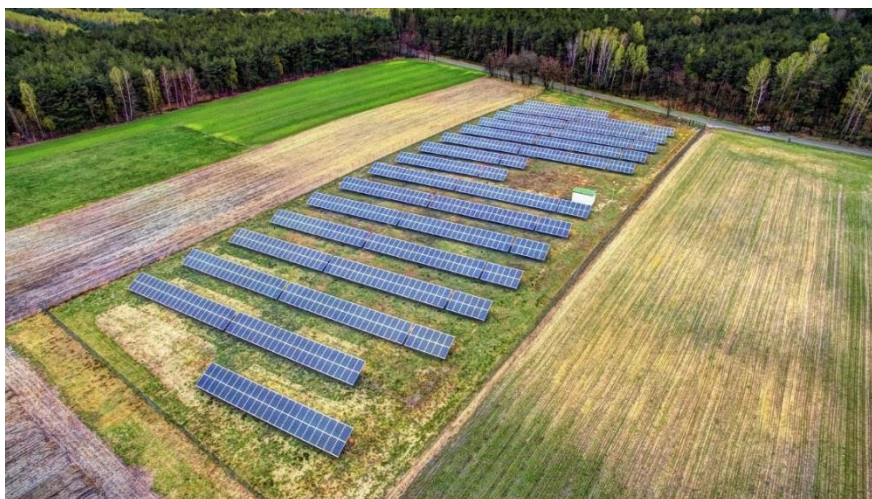
Rysunek 8 Widok przykładowej instalacji fotowoltaicznej z lotu ptaka
