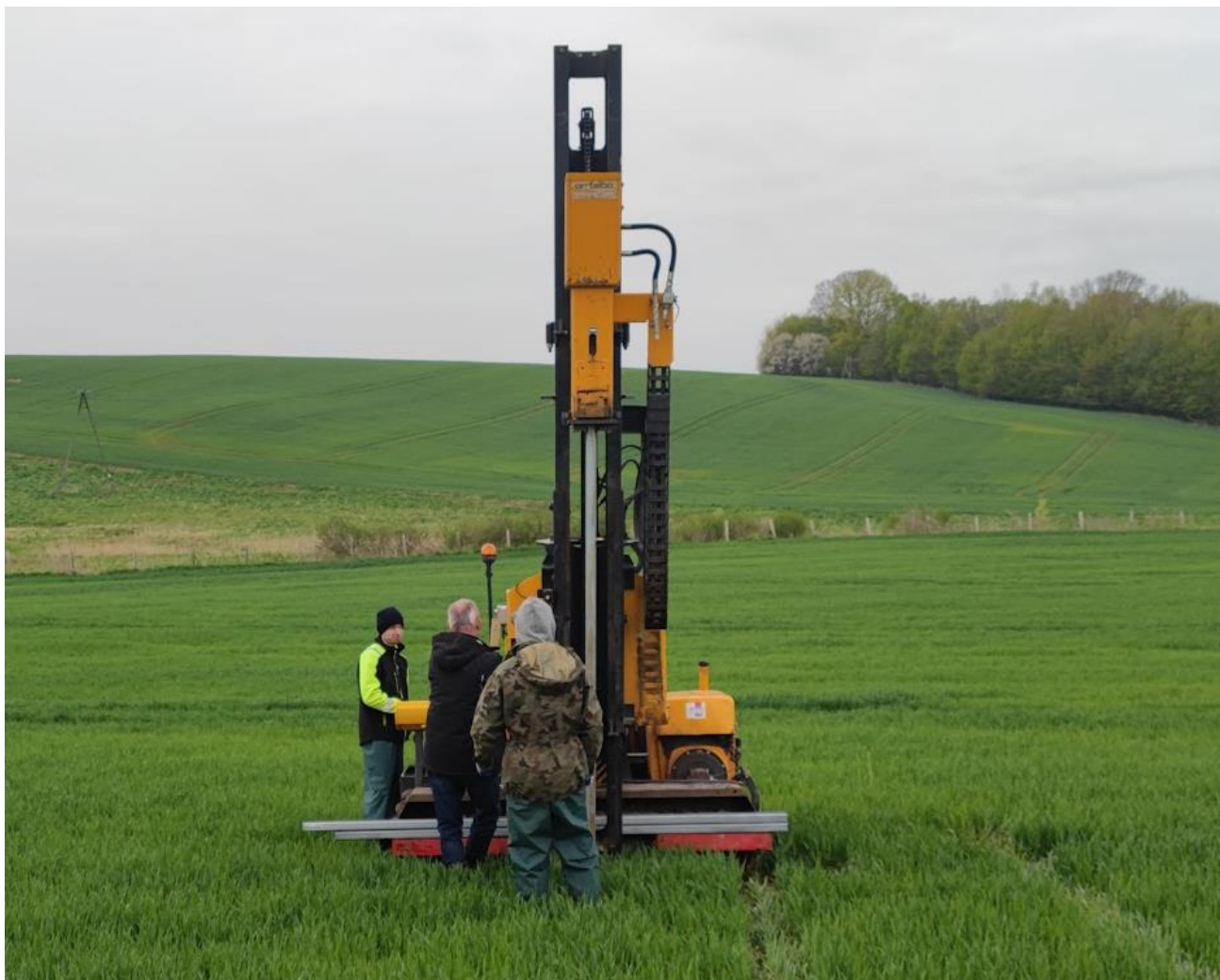
Zdjęcie 1 Kafar wykorzystywany do wbijania konstrukcji wsporczych
