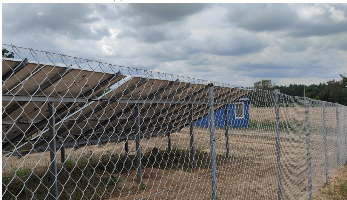
Zdjęcie 6 Przykładowe ogrodzenie farmy fotowoltaicznej.
