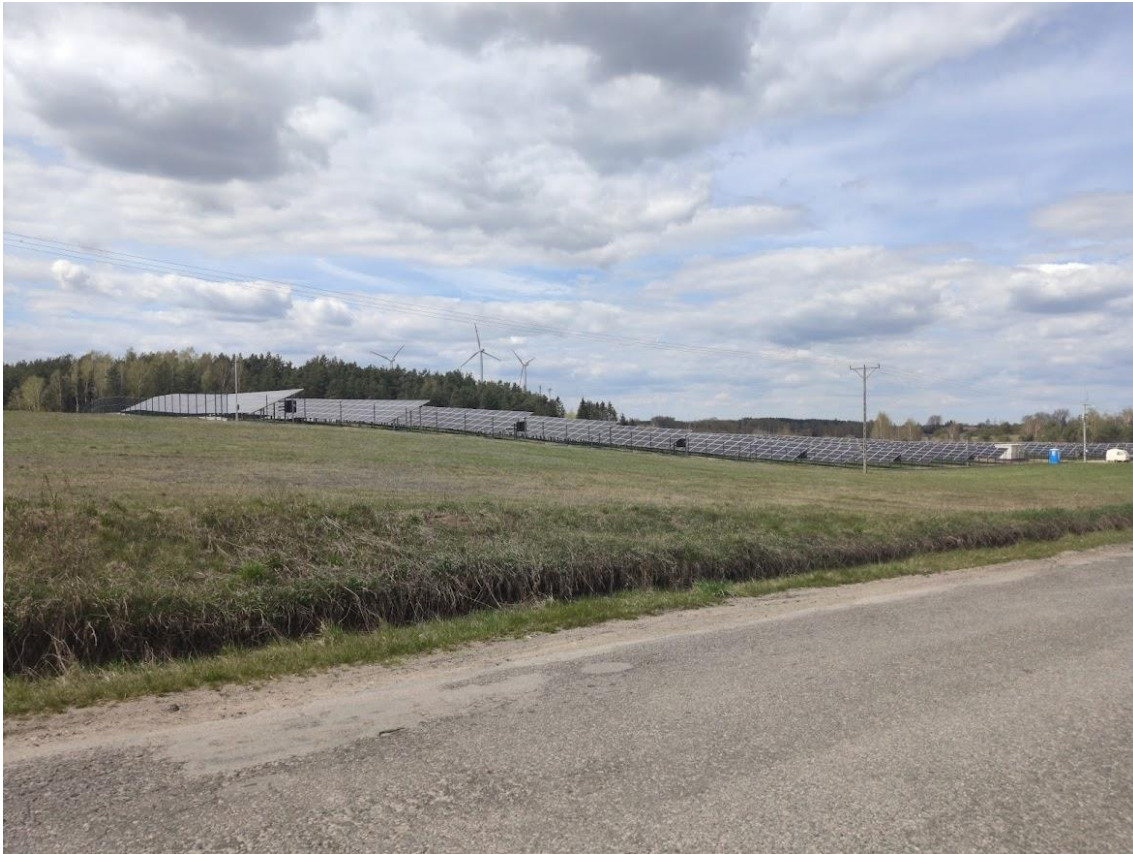
Zdjęcie 7 Widok na instalację fotowoltaiczną
