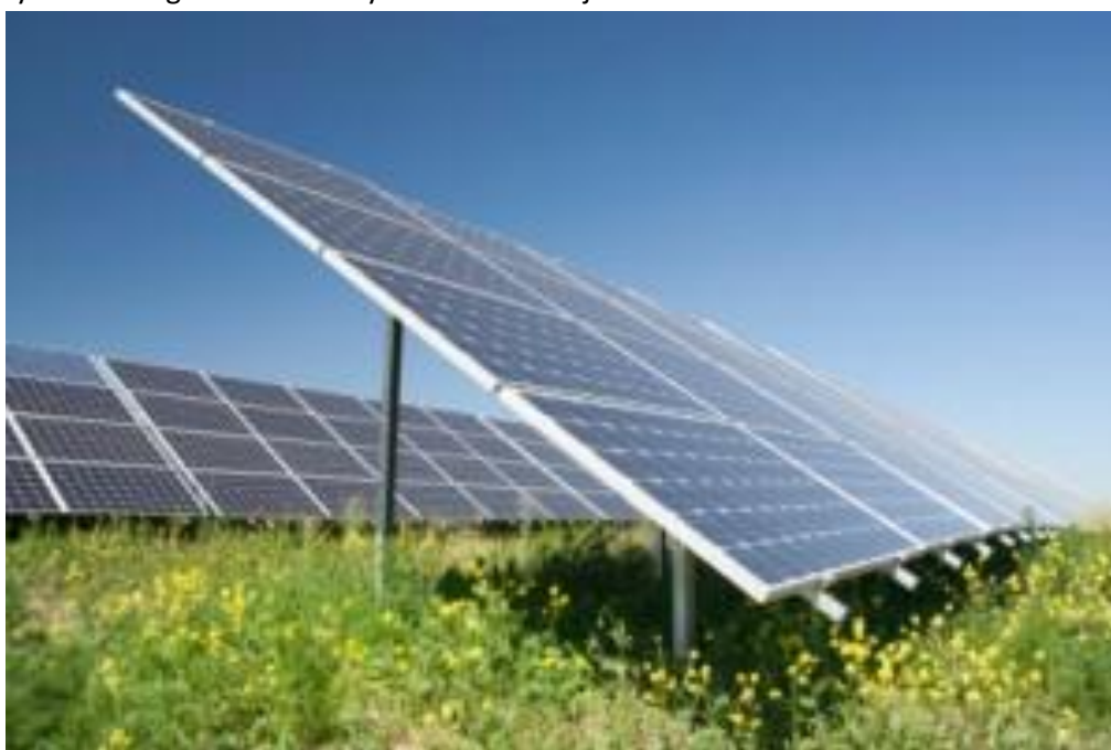
Zdjęcie 2 Sposób montażu paneli fotowoltaicznych na stelazach wbijanych bezpośrednio do gruntu.
