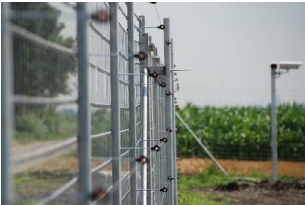
Zdjęcie 1 Przykładowe ogrodzenie farmy fotowoltaicznej
