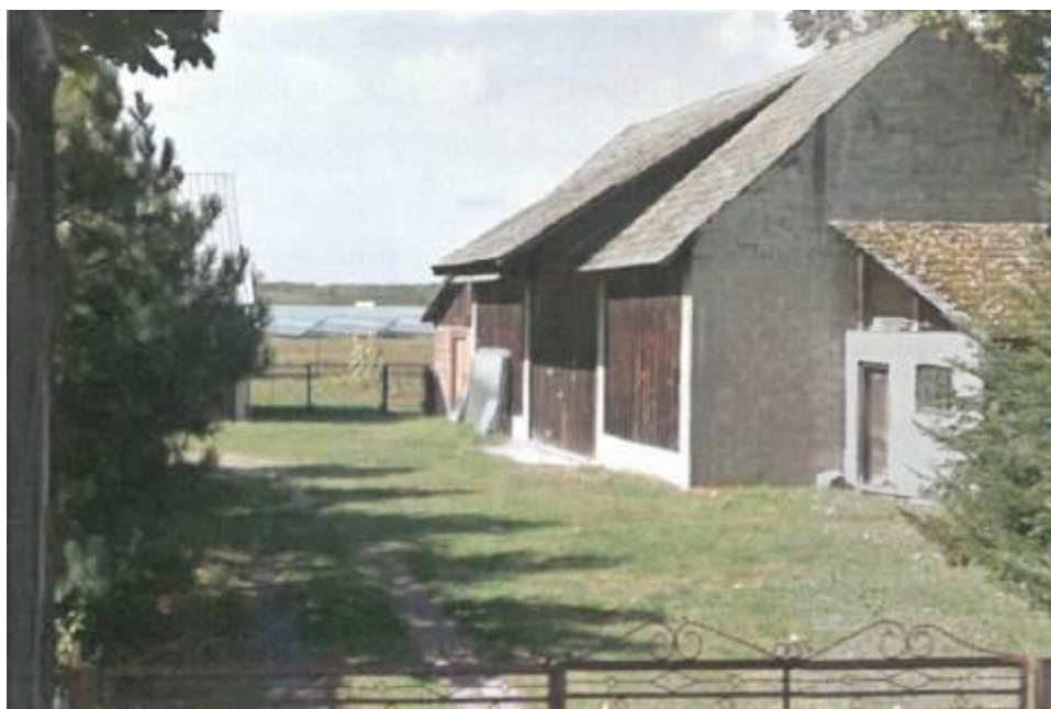
Zdjęcie 5 Widok na instalację fotowoltaiczną z odległości ok. 140 m.
