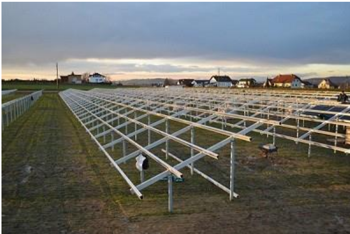
Zdjęcie 3 Szkielety przed montażem paneli, farma solarna NIENBURG 4 MW (Niemcy) (Remor Solar).
