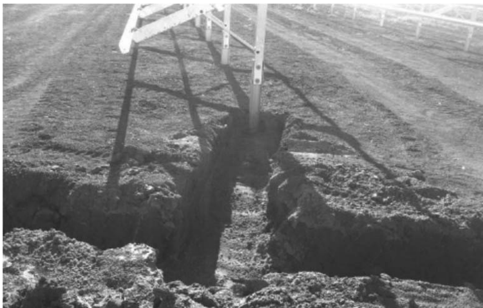
Zdjęcie nr 14. Skręcona konstrukcja nona modułów oraz otworzony wykop pod przewody elektryczne.
