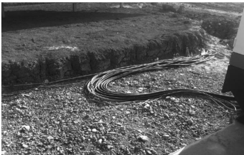
Zdjęcie nr 15. Przewody ułożone w wykopie.
