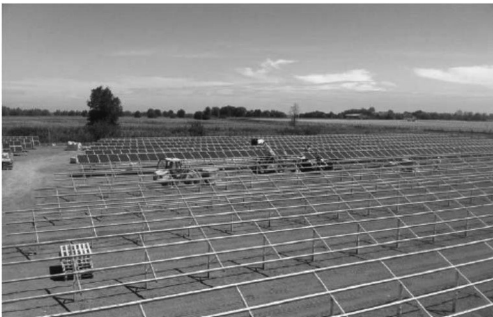
Zdjęcie nr 16. Proces montażu modułów fotowoltaicznych na konstrukcji szkieletowej.
