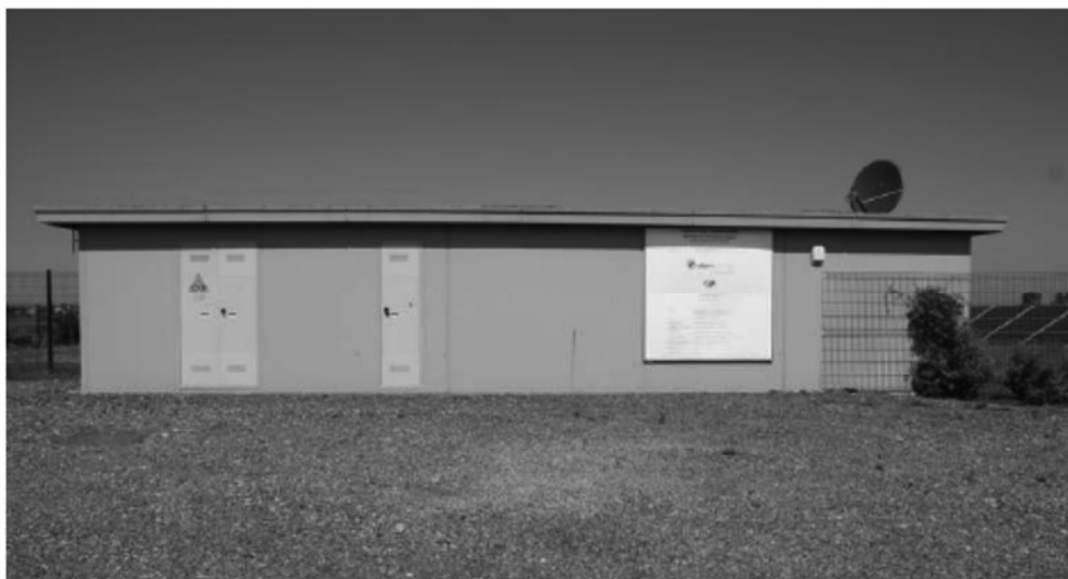
Zdjęcie nr 9. Budynek techniczny widziany od zewnętrznej strony ogrodzenia.
