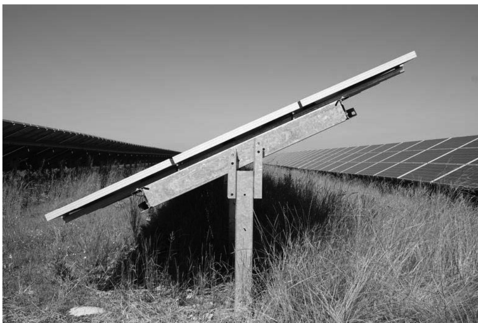
Zdjęcie nr 4. Konstrukcja wsporcza oparta na pojedynczych profilach wbitych bezpośrednio w grunt.
