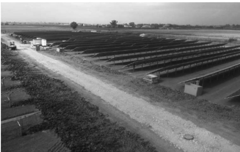
Zdjęcie nr 17. Instalacja odnawialnego źródła energii paneli fotowoltaicznych na jednym z ostatnich etapów budowy, po montażu modułów i zasypaniu przewodów.
