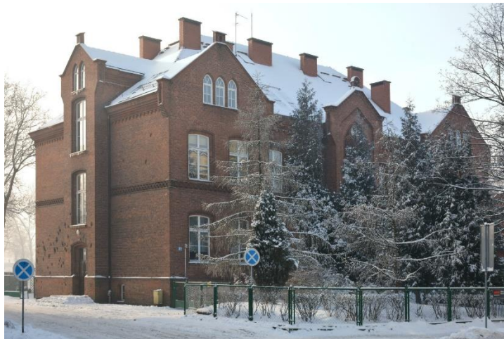
Zdjęcie nr 6 – Szkoła Podstawowa Nr 3 im. Jana Pawła II w Olecku – budynek szkoły (wejście od strony ul. Kolejowej)
