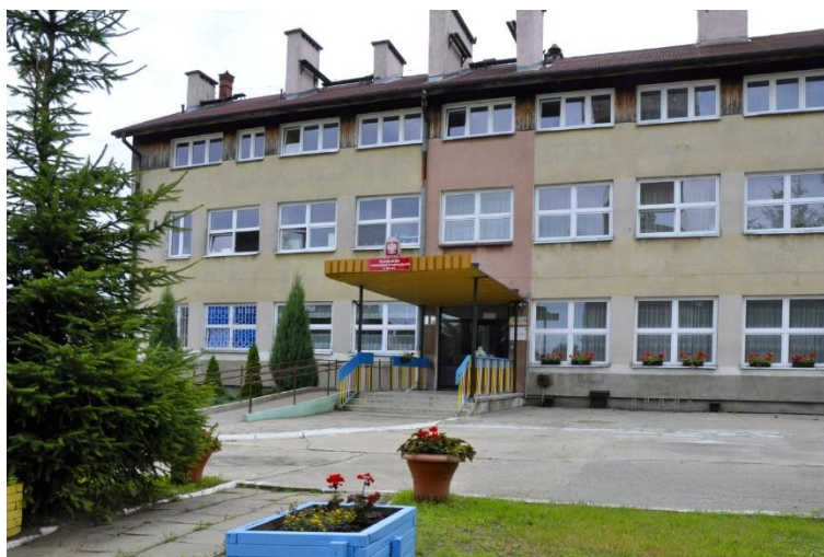
Zdjęcie nr 18 – Przedszkole z Oddziałami Integracyjnymi Krasnal w Olecku – budynek przedszkola
