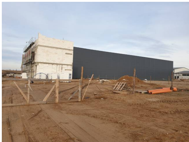
Fot. 1 Miejsce planowanej inwestycji – hala nr 1 (ciemnoszary budynek) oraz część socjalno – biurowa budowanej hali nr 2.
