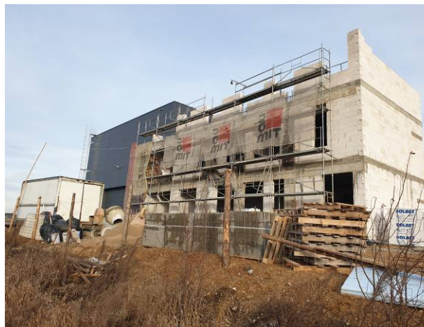
Fot. 2 Miejsce planowanej inwestycji - część socjalno – biurowa budowanej hali nr 2.
