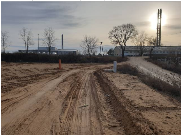
Fot. 5 Wjazd na teren planowanej inwestycji z ulicy Przemysłowej.
