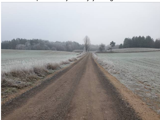
Fot. 9 Teren planowanej inwestycji - droga nr 141019N.
