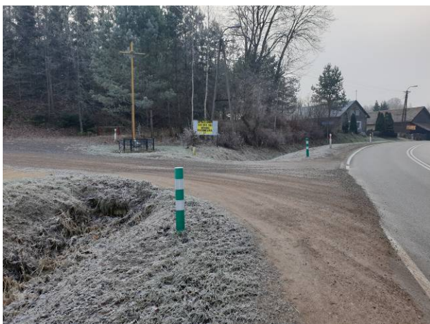
Fot. 1 Teren planowanej inwestycji – skrzyżowanie dk 65 z drogą gminną nr 141019N.
