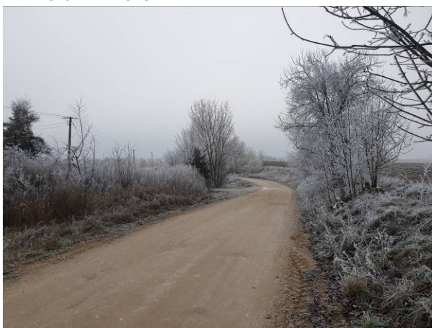
Fot. 15 Teren planowanej inwestycji – droga nr 141019N.
