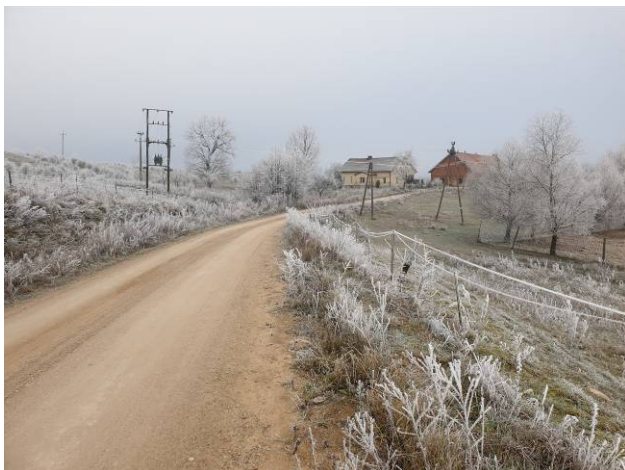
Fot. 19 Teren planowanej inwestycji - droga nr 141048N.
