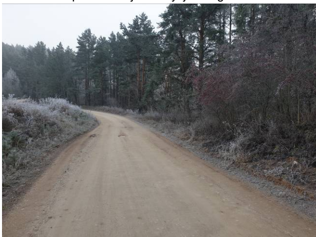
Fot. 11 Teren planowanej inwestycji - droga nr 141019N.
