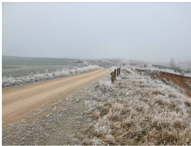
Fot. 22 Teren planowanej inwestycji - droga nr 141048N.
