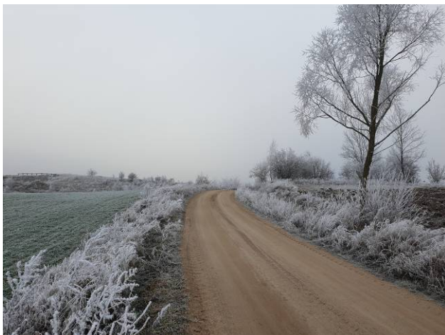
Fot. 25 Teren planowanej inwestycji - droga nr 141048N.
