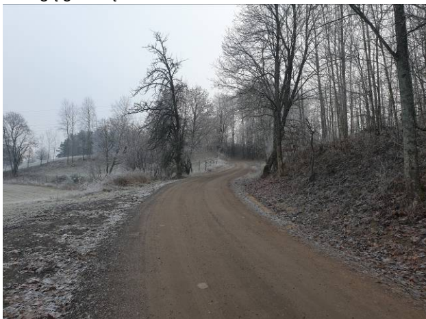
Fot. 3 Teren planowanej inwestycji - droga nr 141019N.
