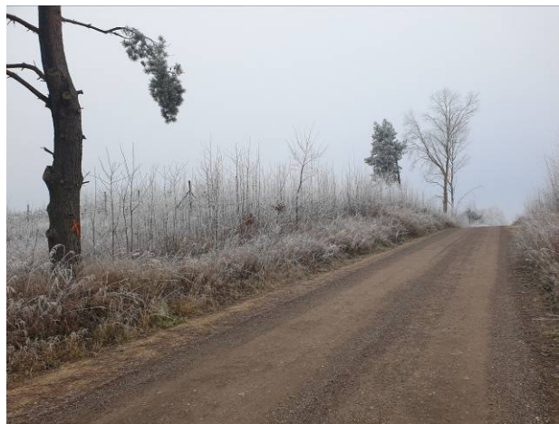
Fot. 8 Teren planowanej inwestycji - droga nr 141019N.
