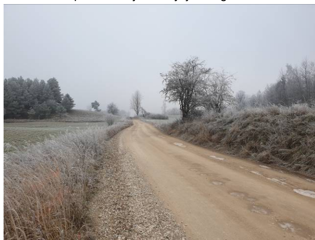
Fot. 10 Teren planowanej inwestycji - droga nr 141019N.
