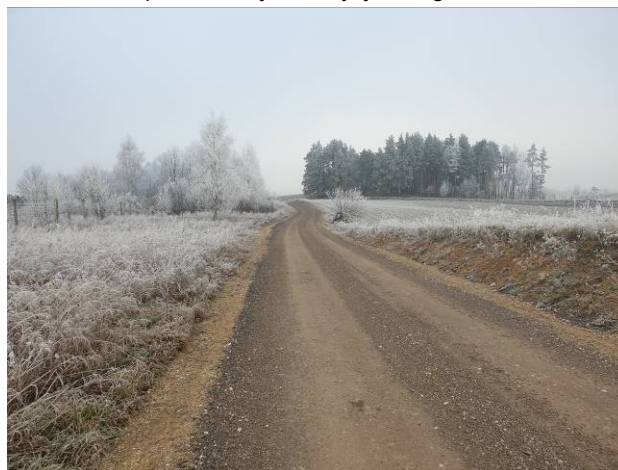
Fot. 6 Teren planowanej inwestycji - droga nr 141019N.
