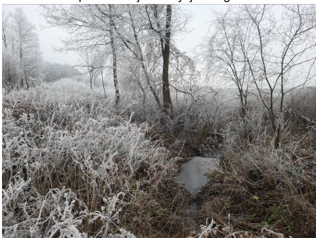
Fot. 27 Rów melioracyjny przy drodze nr 141019N.
