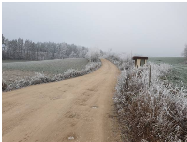
Fot. 14 Teren planowanej inwestycji - droga nr 141019N.
