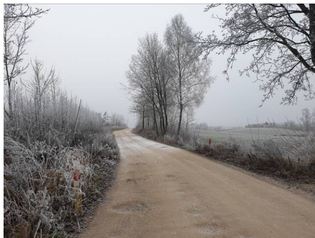
Fot. 12 Teren planowanej inwestycji - droga nr 141019N.
