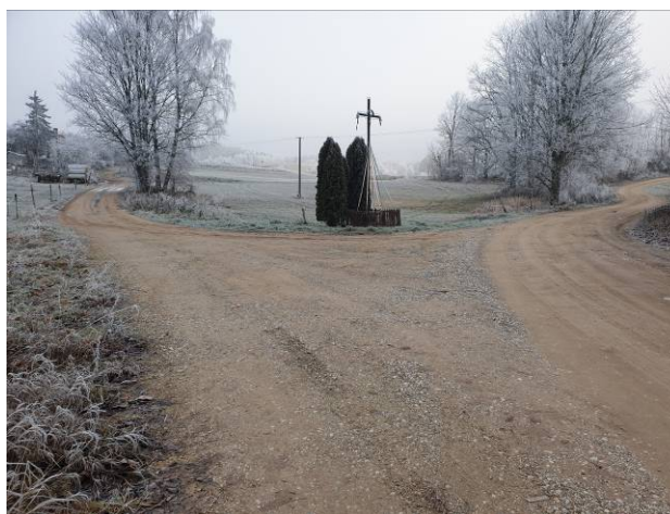
Fot. 16 Koniec opracowania – skrzyżowanie drogi nr 141019N z drogą powiatową.
