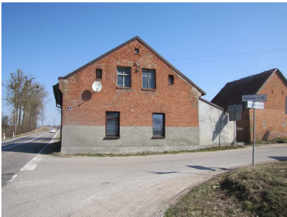
Fot. 3. Budynek mieszkalny w m. Kukowo przeznaczony do rozbiórki, km 43+750 drogi krajowej nr 65 (M. Jastrzębska-Milewska, 2018).
