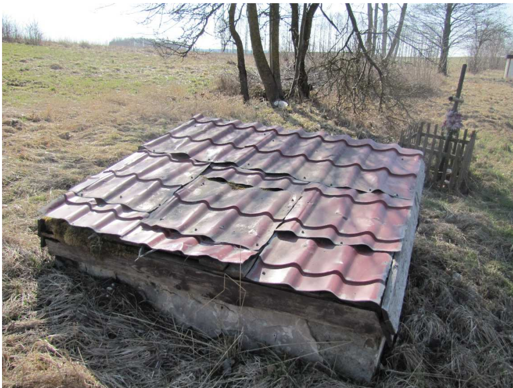
Fot. 5. Ziemiańska w m. Kukowo przeznaczona do rozbiórki, km 43+800 drogi krajowej nr 65 (M. Jastrzębska-Milewska, 2018).
