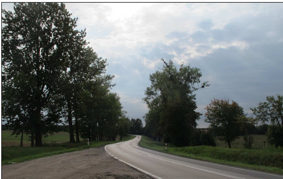
Fot. 13. Teren inwestycji, km ok. 47+900 drogi krajowej nr 65 (M. Grabowski, 2018).
