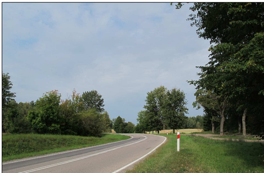
Fot. 14. Teren inwestycji, km ok. 47+900 drogi krajowej nr 65 (M. Grabowski, 2018).
