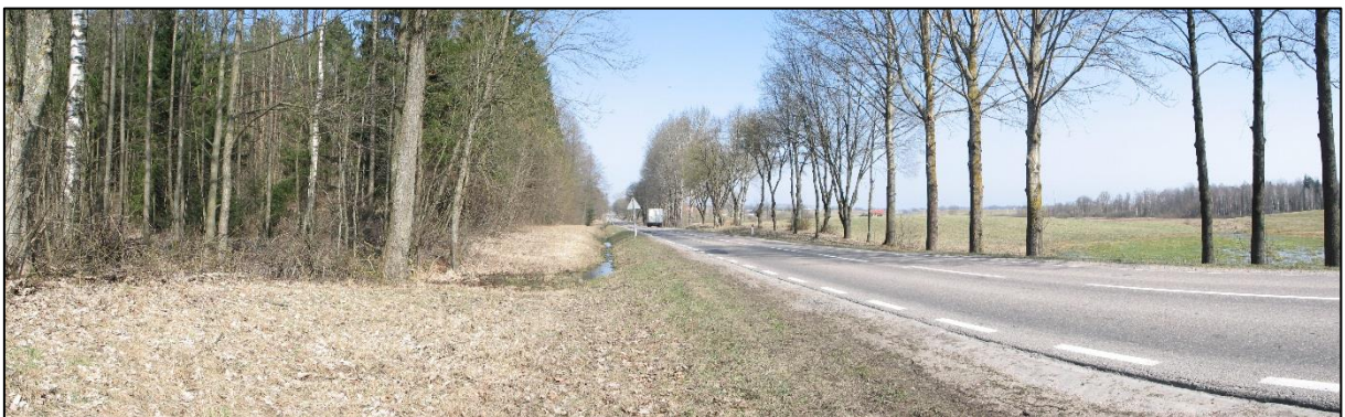
Fot. 2. Teren inwestycji na wysokości około km 46+200 (K.Lubelska-Gawryszewska, 2018).
