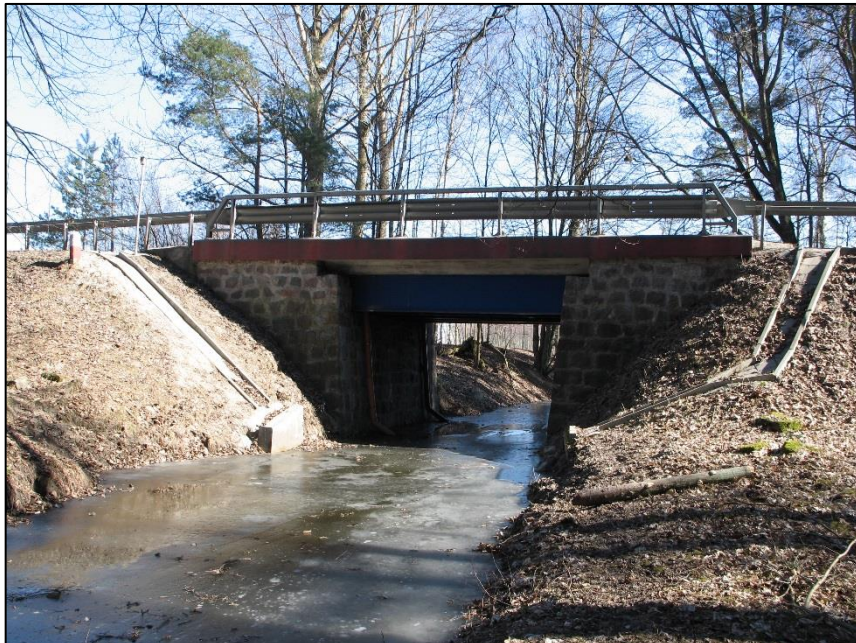
Fot. 42. Przepust w około km 48+800 wykorzystywany do migracji przez bobra europejskiego oraz płazy – brak półek dla zwierząt, uniemożliwia migrację innych gatunków średnich ssaków (K.Lubelska-Gawryszewska, 2018).
