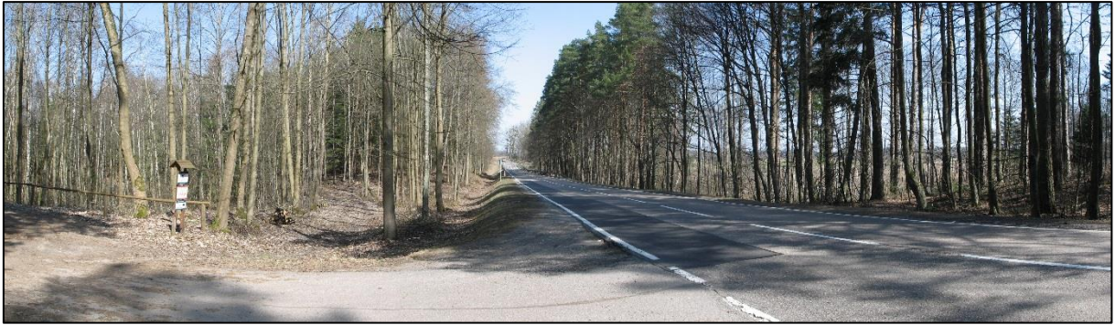
Fot. 3. Teren inwestycji na wysokości około km 49+050 (K.Lubelska-Gawryszewska, 2018).
