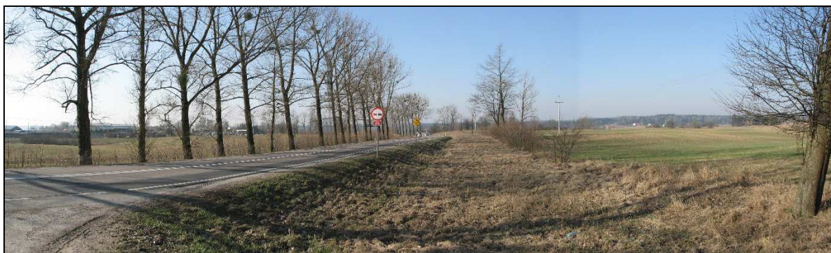
Fot. 1. Teren inwestycji na wysokości około km 43+289 - początek analizowanego odcinka (K.Lubelska-Gawryszewska, 2018).
