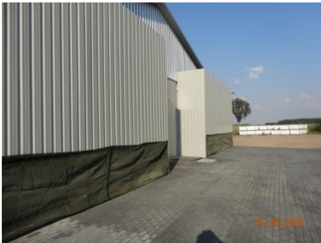
Rysunek nr 6 : Sposób obudowy wentylatorów ściennych MASTER
