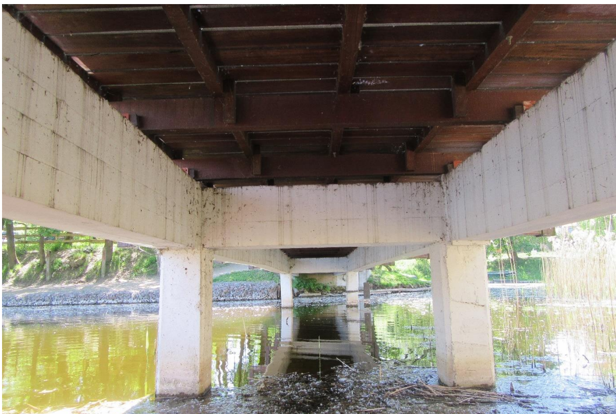
Rysunek 4 - Kontrola spodniej części mostu z użyciem kajaka w poszukiwaniu gniazd ptasich.
