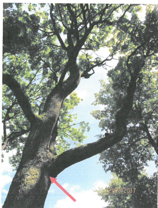
Fot.6. Klon do usunięcia - poprawienie statyki
