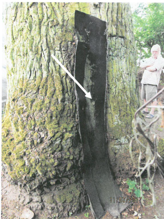
Fot.9. Zasłonięty ubytek wgłębny
