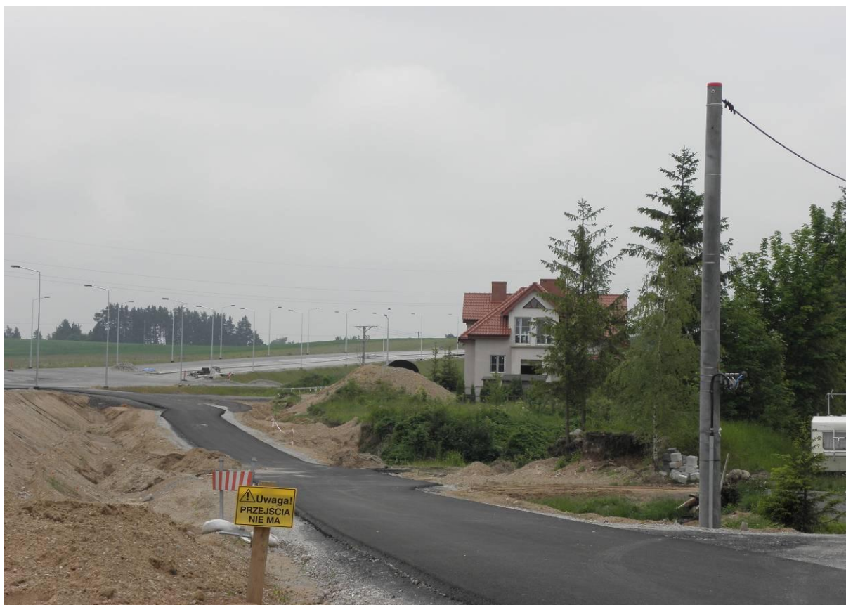
zdz.1 Budowa obwodnicy miasta Olecka
