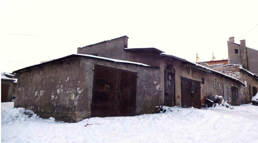
Fot. 8. Budynki od lewej nr 10 i 9.
