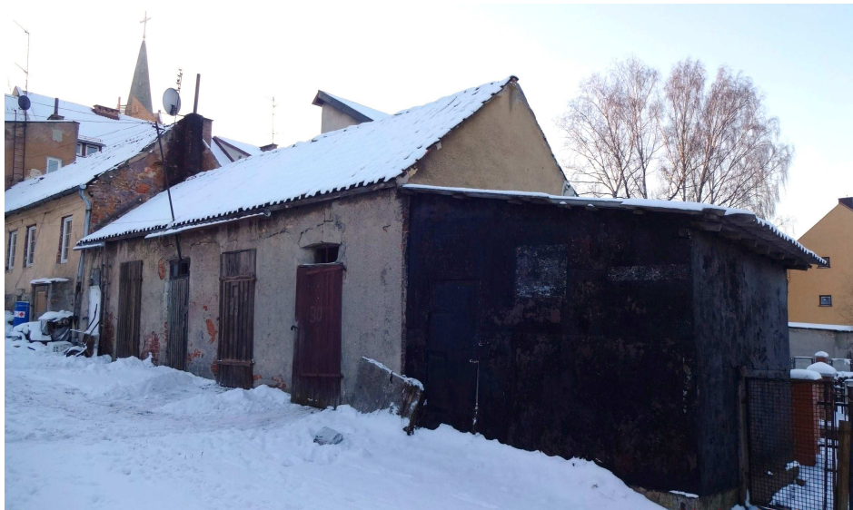
Fot. 1. Budynki od lewej nr 1 i 2.
