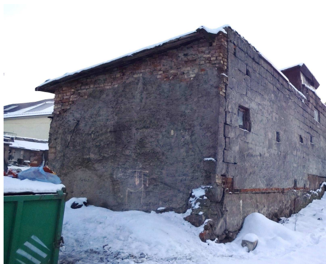
Fot. 6. Tył budynku nr 7.
