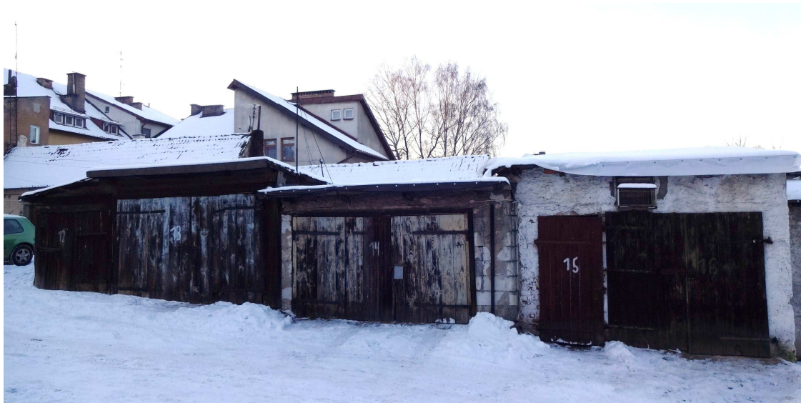
Fot. 2. Budynki od lewej nr 3, 4 i 5.
