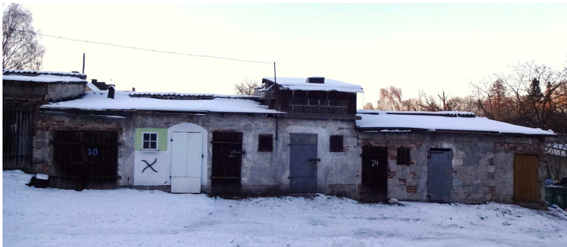
Fot. 5. Budynki od lewej nr 6 i 7.
