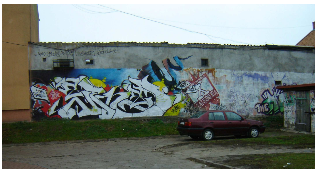
Fot. 12. Tył budynku nr 12.
