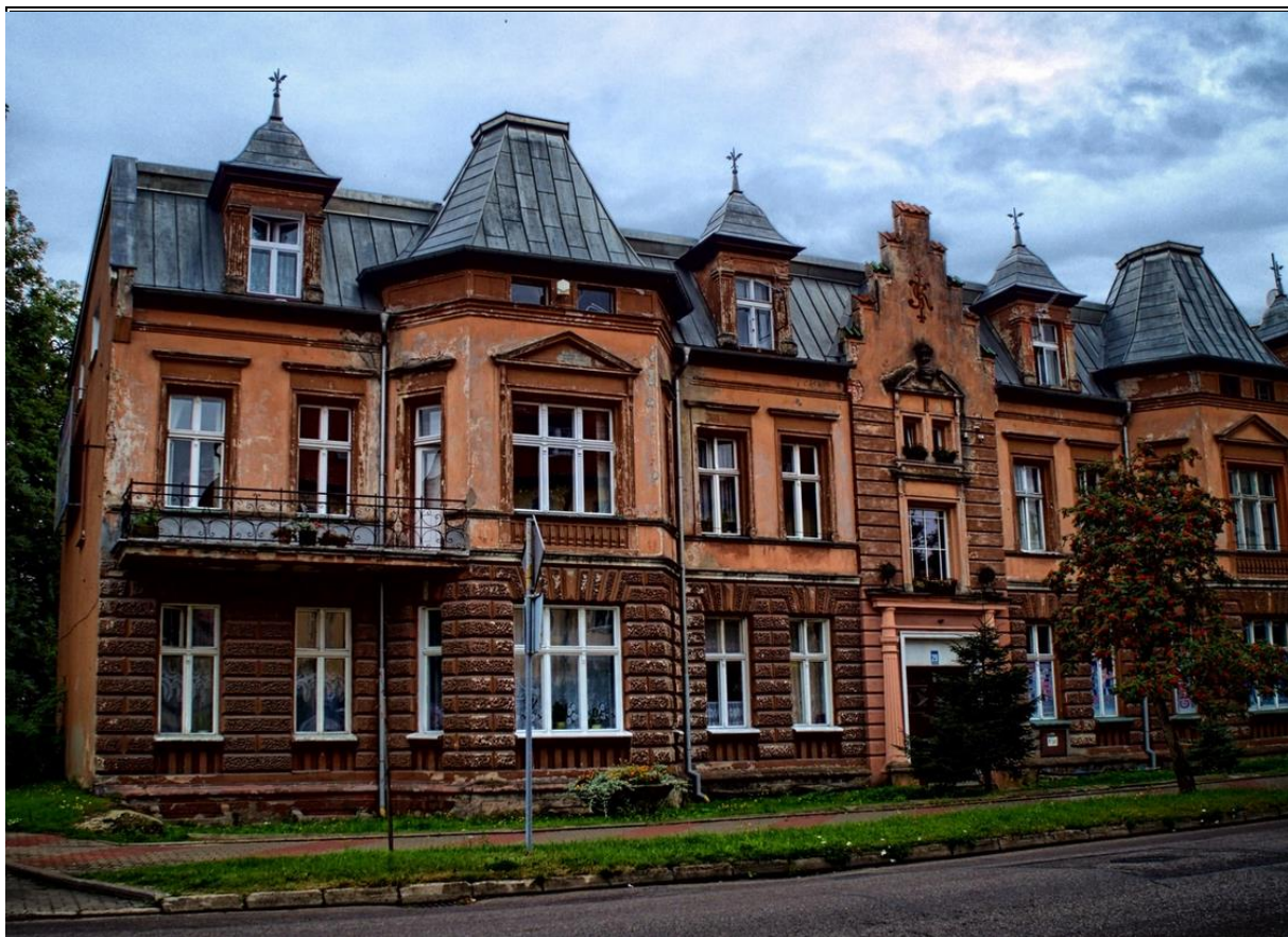
Fotografia 12. Budynek przy ulicy Kolejowej 29 w Olecku
