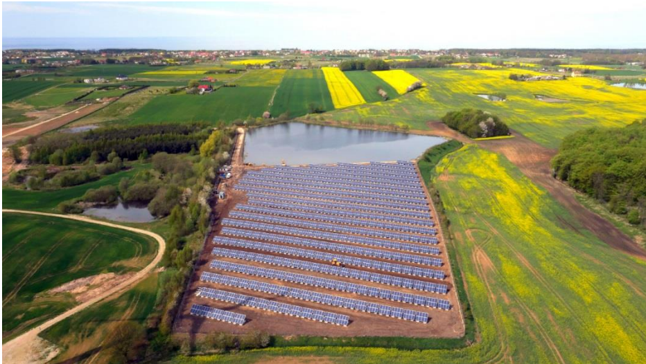
Farma fotowoltaiczna na zrehabilitowanym wysypisku śmieci w Ustroniu Morskim 2015 r. i 2017 r.
