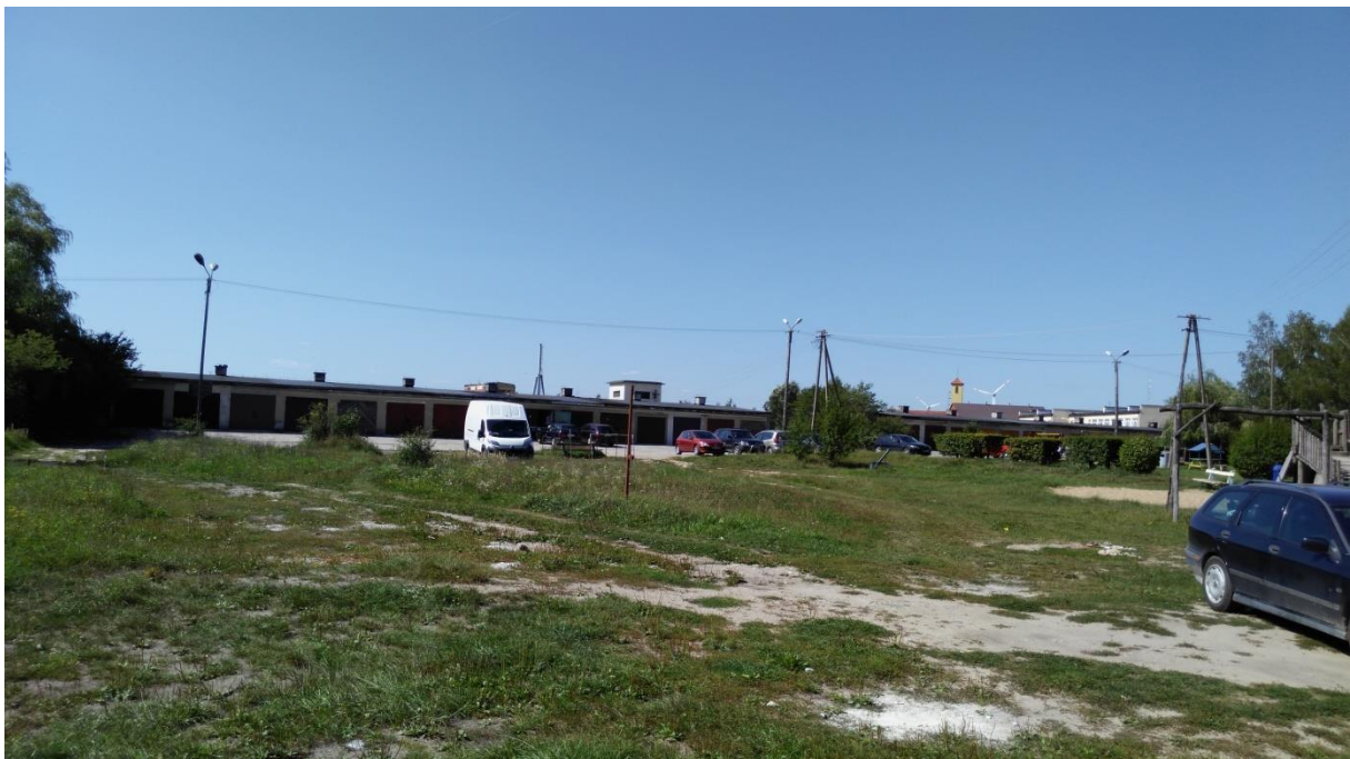
Działka nr 145/22, obręb Olecko 1, gmina Olecko - budynki garażowe.
